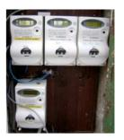
In ogni appartamento ci sono i vecchi interruttori magnetotermici ed i nuovi interruttori differenziali. I magnetotermici di norma non si aprono perché i differenziali ed i contatori esterni sono più sensibili e scattano prima. Fare attenzione che il magnetotermico di A1 non funziona bene, è meglio non toccarlo, se si apre va chiuso smontando il pannello.
